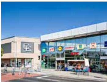
Anlageobjekt in Hofheim
